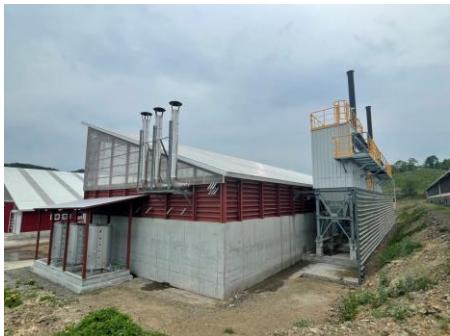
バグフィルタを施設裏面に設置
