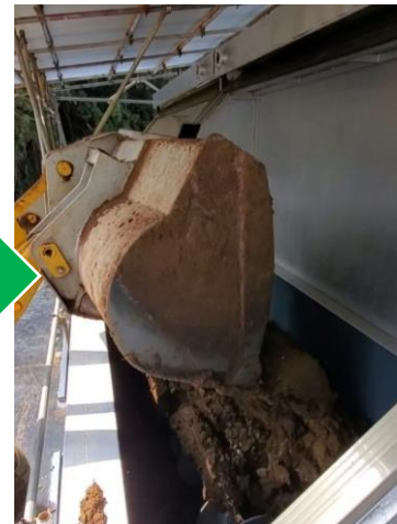
原料投入作業
